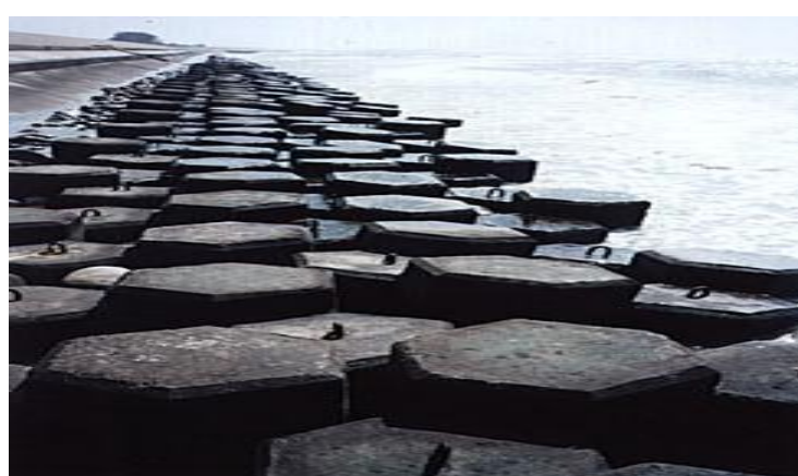
使用卜特蘭高爐水泥產製消波塊
