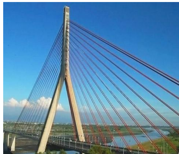
高屏溪斜張橋
