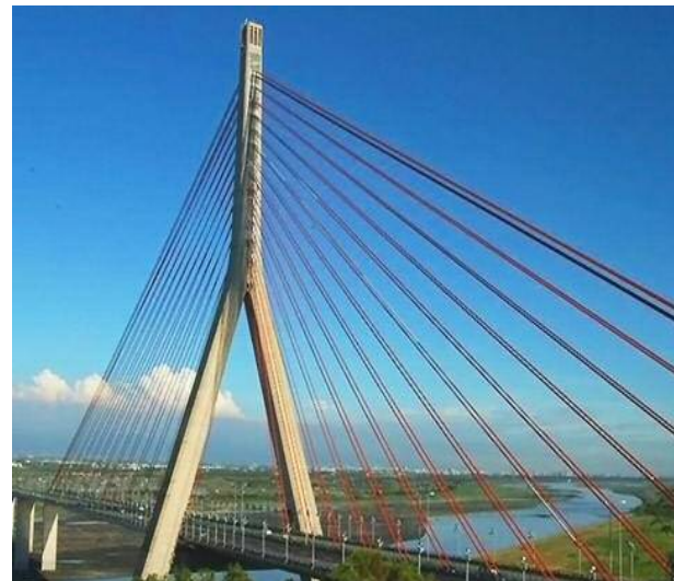
高屏溪斜張橋
