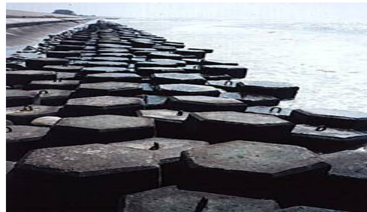
使用卜特蘭高爐爐渣水泥產製消波塊
