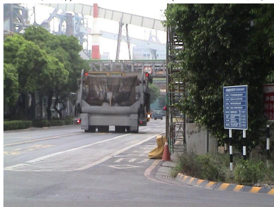
圖 12 轉爐石瀝青混凝土應用於動力東路 (96.06 試鋪，100.03.07 拍攝)
