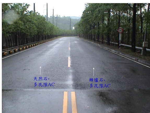
圖 13 轉爐石瀝青應用於中聯進廠道路 (96.08.05 試鋪，98.09.01 拍攝)
