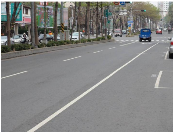
圖 10 轉爐石瀝青應用於高雄市澄清路 (98.04.11 試鋪，100.03.07 拍攝)
