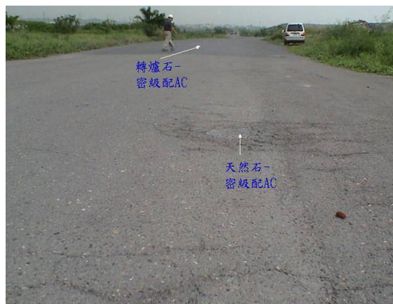
圖 14 轉爐石瀝青應用於南星計畫道路-1 (92.04 試鋪，100.03.07 拍攝)
