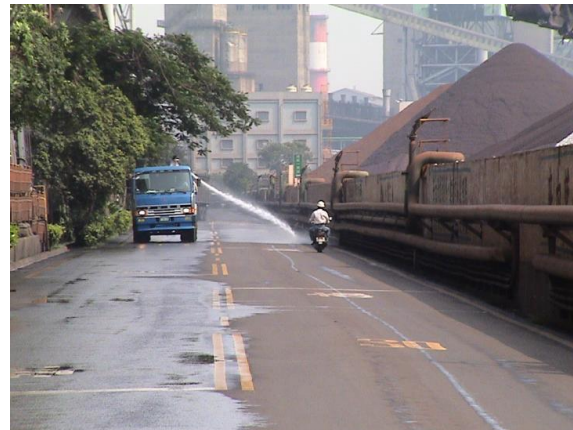
圖 11 轉爐石瀝青應用於原料一東路 (98.03.12 試鋪，100.03.09 拍攝)
