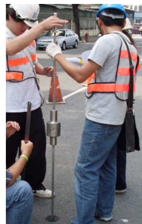
圖 10 DCP 現場試驗情形
