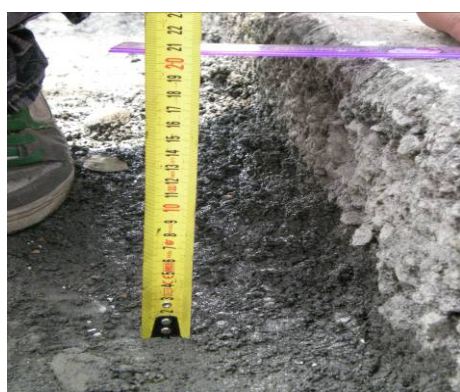
圖 14 路口轉彎處鋪築厚度 20cm
