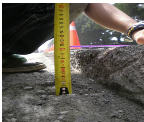
圖 16 外車道直線段鋪築 10cm
