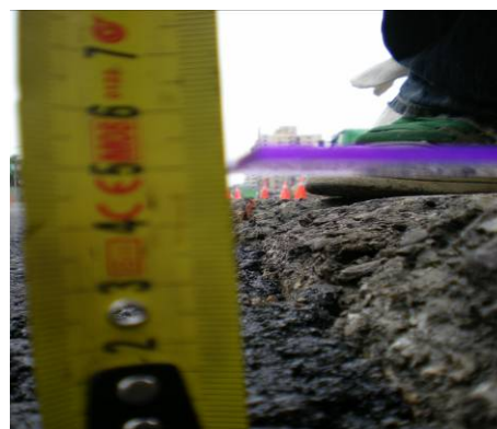
圖 17 機車道鋪築厚度 5cm
