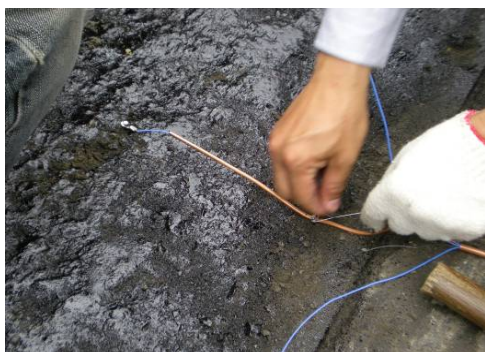
圖 31 現場感溫線埋設情形
