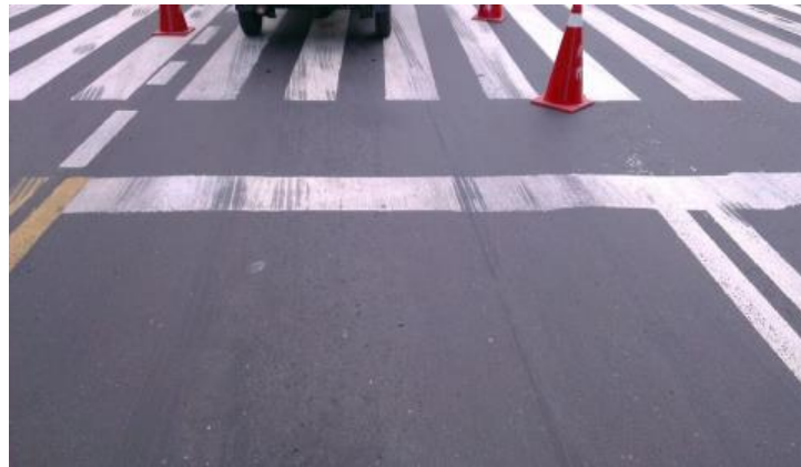
圖 49 鋪面滑動情形
