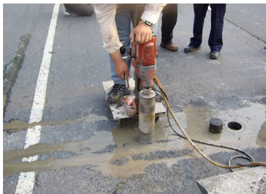
圖 24 現場鑽心取樣情形
