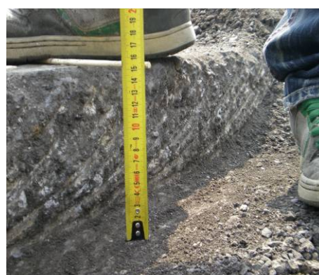
圖 15 內車道直線段鋪築厚度 15cm
