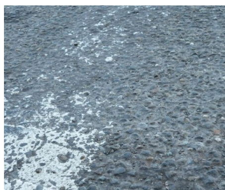
圖 6 原路段粒料剝離近照
