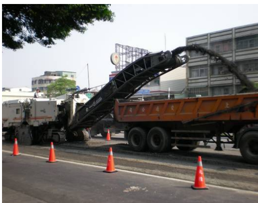
圖 18 現地施工刨除情形
