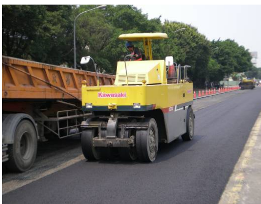
圖 22 現地鋪面滾壓情形
