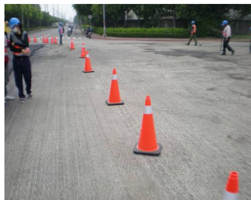
圖 19 施工刨除面保持清潔
