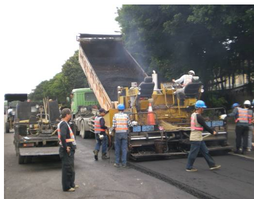
圖 21 路面鋪築現況
