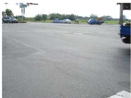
(a) 多處管線開挖及修補
