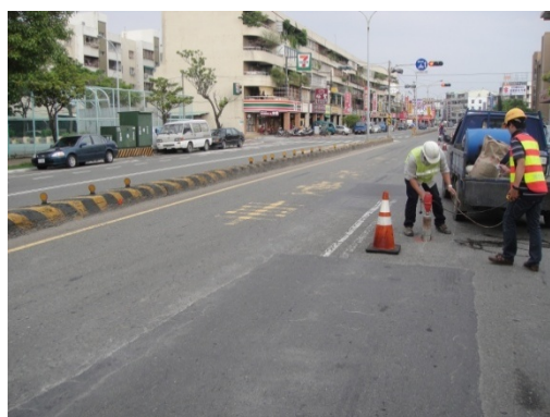
(a) 管線開挖修補
