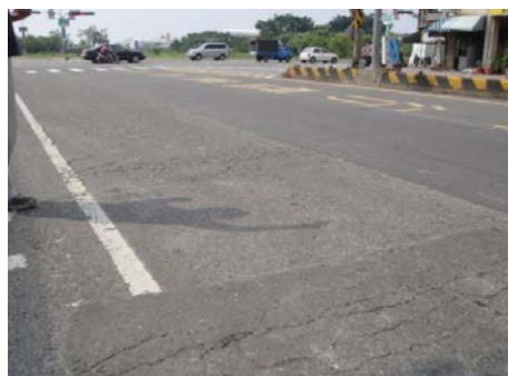
(a) 管線挖掘修補
