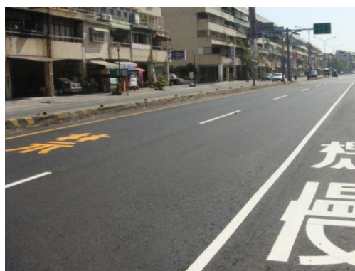
(a) 鋪築後路面整齊平順
