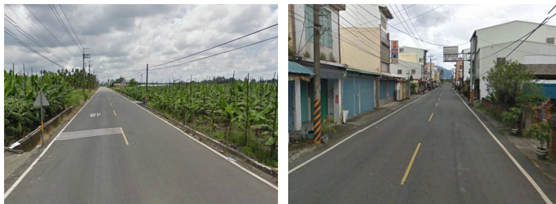
(a) 轉爐石瀝青混凝土鋪面
