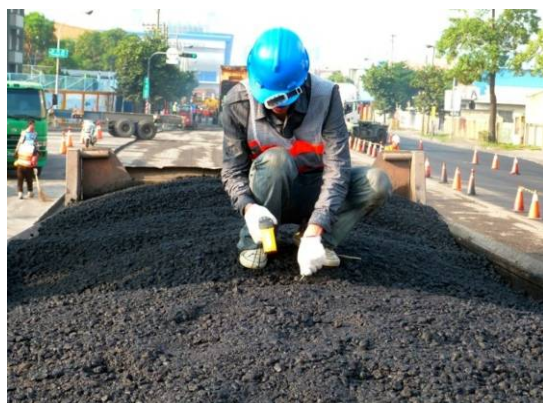
圖 8 量測載運卡車溫度
