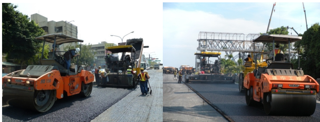
圖 8 轉爐石 SMA 瀝青混凝土鋪築滾壓 圖 9 天然石 SMA 瀝青混凝土鋪築滾壓
