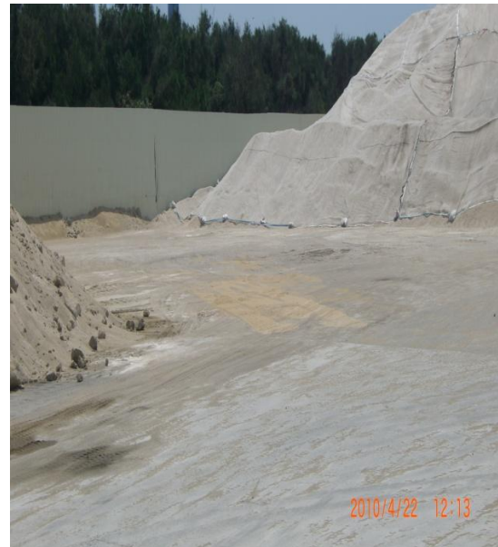
圖 8 料源堆置場現況-2
