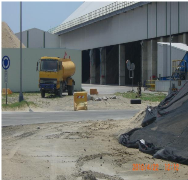
圖 7 料源堆置場現況-1
