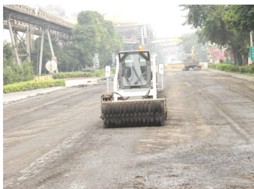
圖 48 剷除挖除、清潔整理
