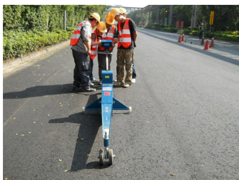
圖 56 工地現平坦度檢驗
