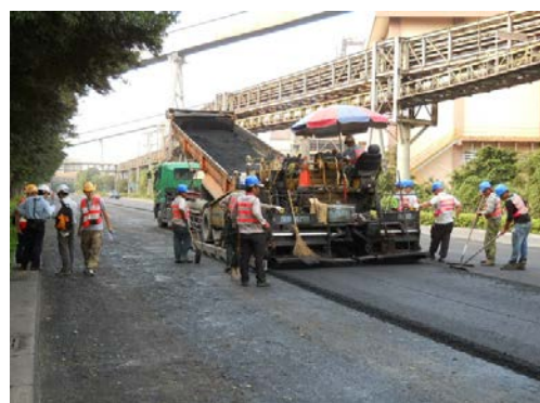
圖 51 第一層 5cm 鋪築
