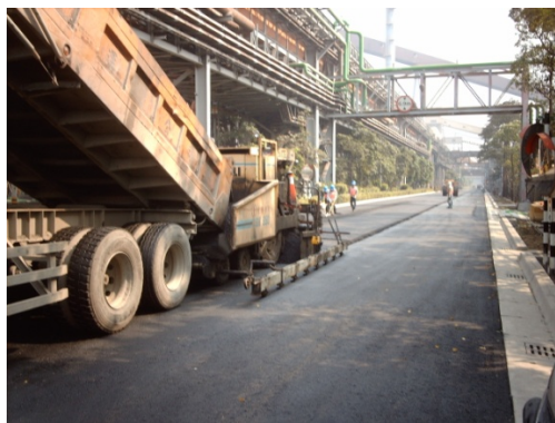
圖 52 第二層 5cm 鋪築
