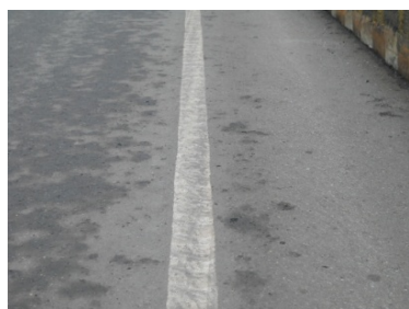
圖 32 瀝青包裹不全粒料脫落
