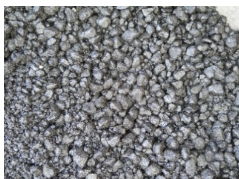
圖46 濕拌拌合完整均勻
