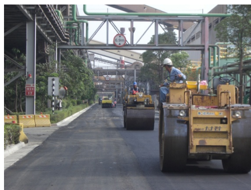
圖 53 滾動壓實初、中、終壓
