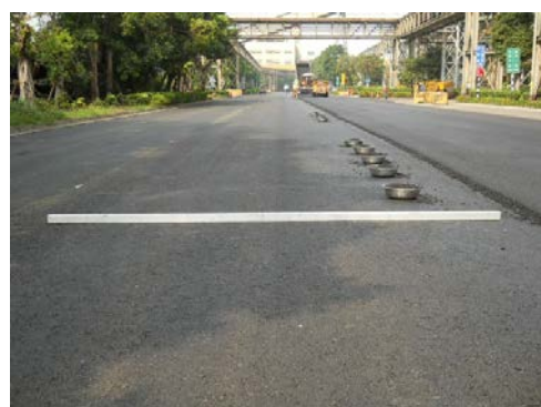
圖 55 工地現場取樣檢驗
