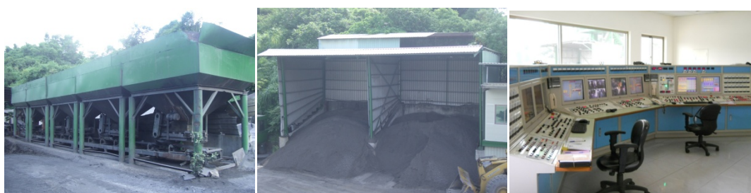
圖38 骨材分倉進料 圖39 骨材堆置場分隔防水 圖40機具自動電腦化
