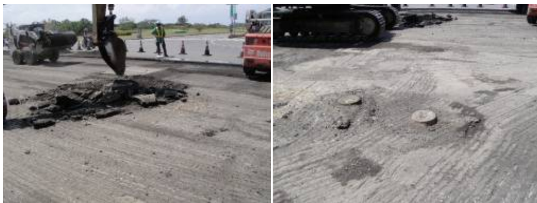
(a)挖土機挖除瀝青混凝土
