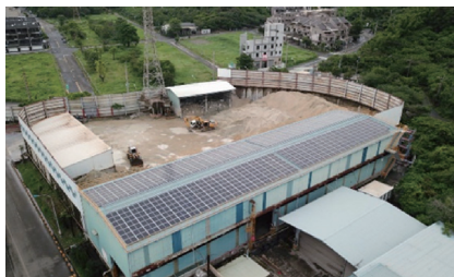
南部研磨廠戊-1 棟
