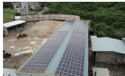
南部研磨廠戊-1 棟
